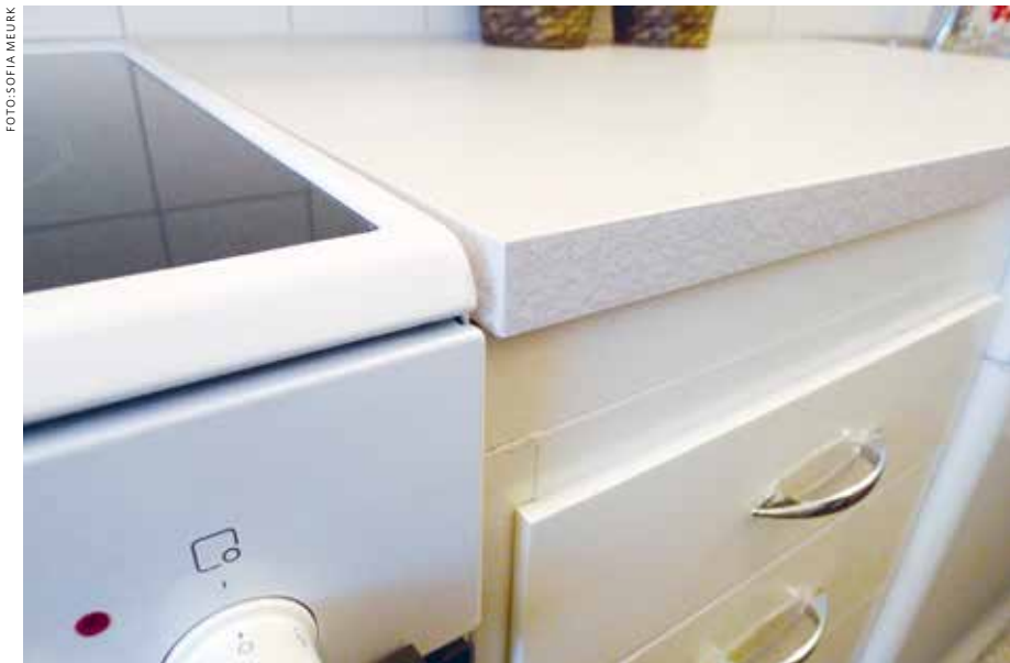
Bänkskivor i 1960-talskök ska ha raka kanter. Här ett exempel med Sigvard Bernadottes klassiska virrvarrmönster, som återigen är en storsäljare.
