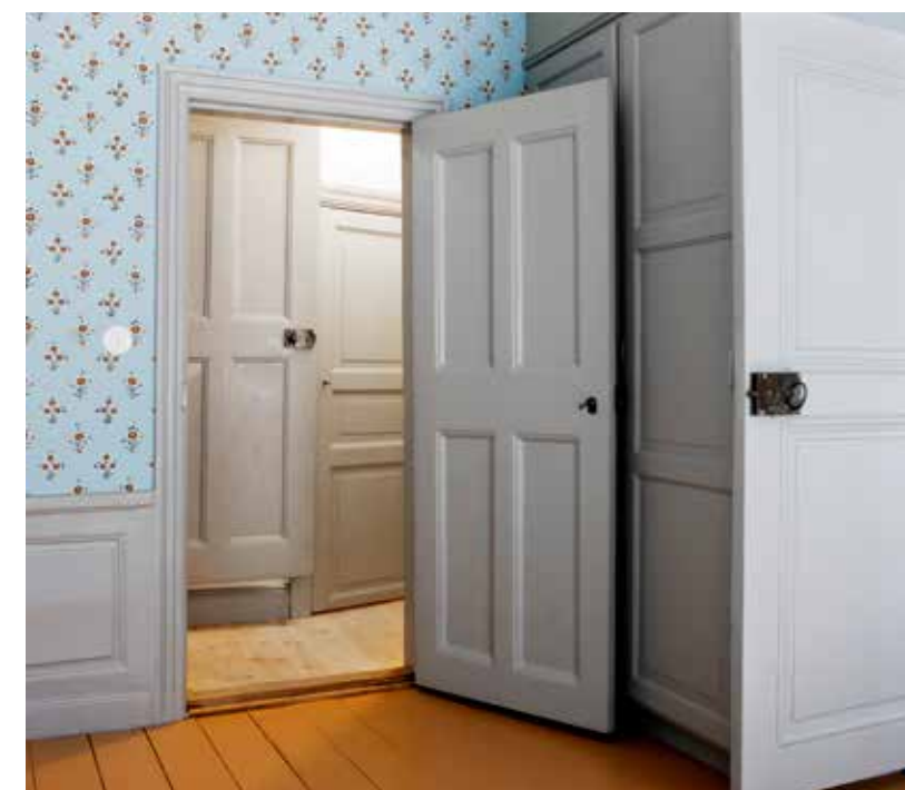
Den lilla dörren leder ut i trapphuset och den med kammarlåset går till badrummet. Däremellan platsbyggda garderober.
