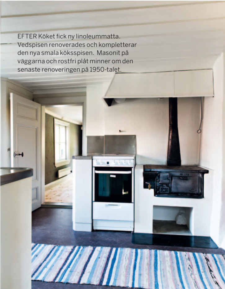
Ny platsbyggd köksinredning, linoljefärgsmålade snickerier, rostfri bänksplåt och stänkskydd i plåt.
