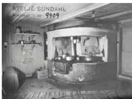
Det här fotot från 1943 var viktigt när vedspisen skulle tillbaka på plats. Spisen hade tagits bort under senare tid och dess plats murats igen. På hällen hade man lagt keramiska plattor.
