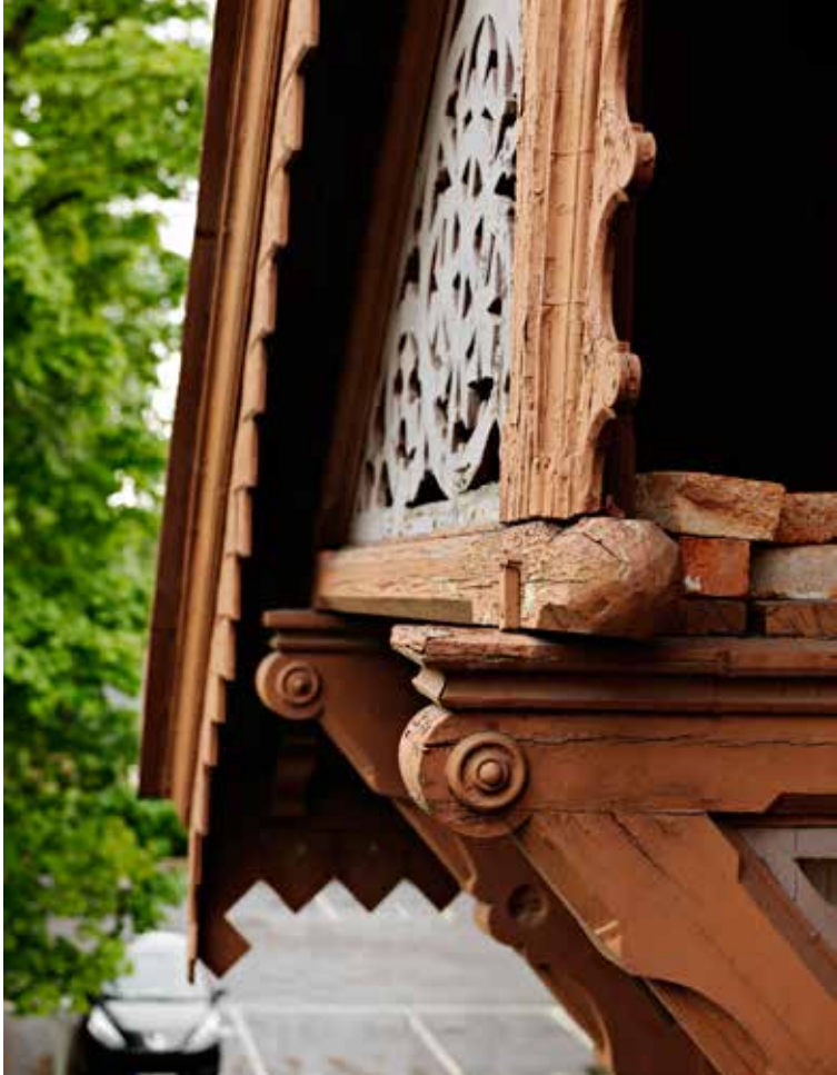
Trots krackelerad färg är fasadutsmyckningarna i gott skick. Med ångsågens intåg i mitten av 1800-talet kunde man massproducera spontade brädor, profilerade lister och lövsågerier för fasadutsmyckning.
